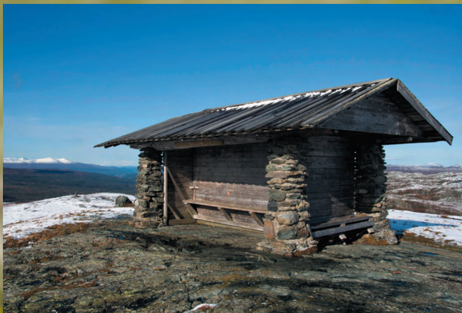
Vindarnas Tempel. 842,5 m.ö.h. Bilden fotograferad i slutet av september.
